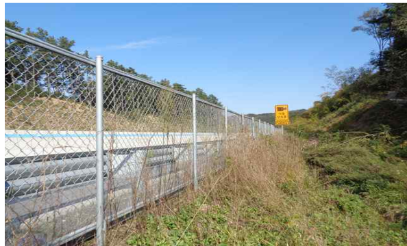
낙석방지 울타리 전경
